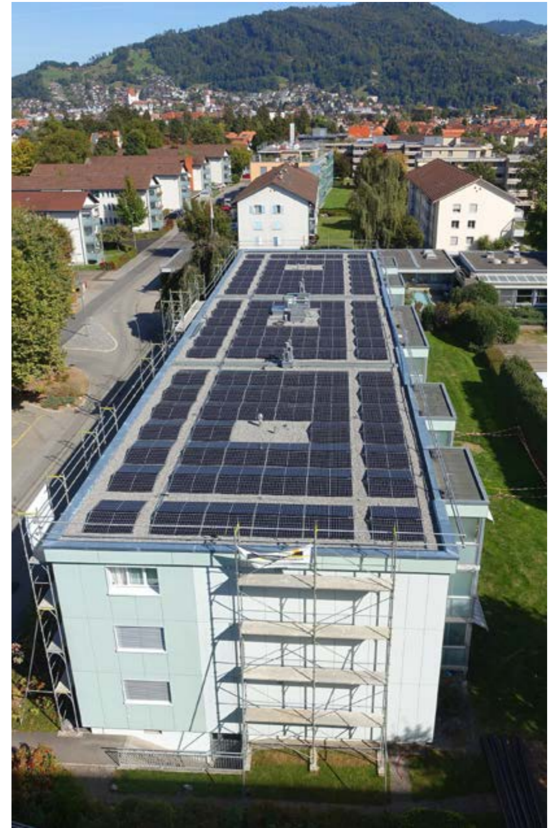
Die Flachdächer der fünf Bestandsbauten boten reichlich Platz für die Installation einer PV-Anlage.
