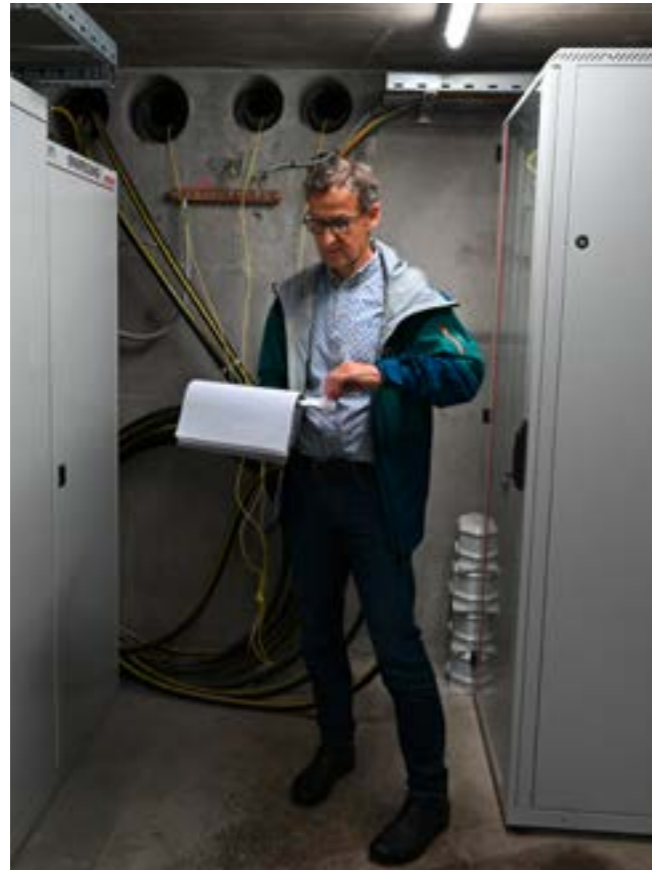
Zur Umsetzung des neuen Areal-ZEV waren umfangreiche Planungs- und Bauarbeiten für die neue Elektroinstallation notwendig.
